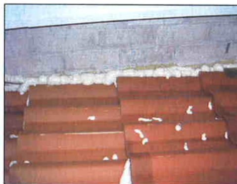
Fotografías 16 Sellado con espuma de poliuretano
