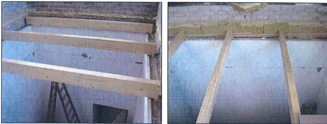
Fotografías 2 y 3 Colocación de las vigas en la sala de transmisión del laboratorio
