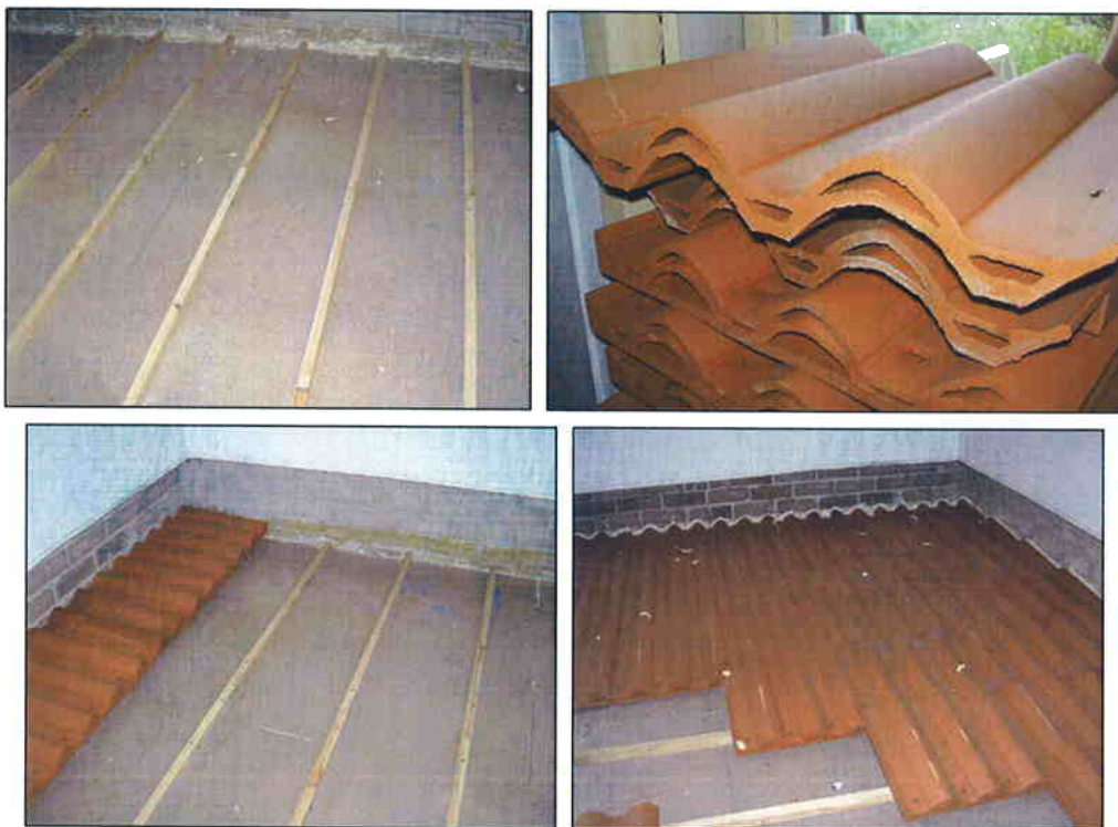
Fotografías 12, 13, 14 y 15 Colocación de las tejas cerámicas sobre rastreles
