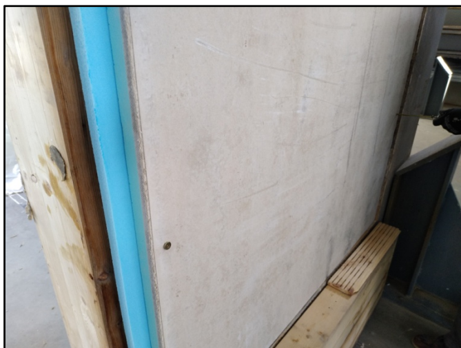
Detalle de colocación del panel sobre soporte estructural, con vista del macho, del panel TFbcY / 12-60-12
