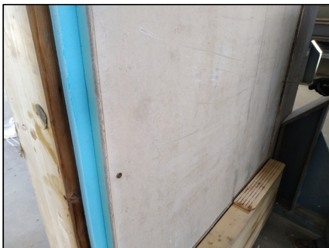
Detalle de colocación del panel sobre soporte estructural, con vista del macho
