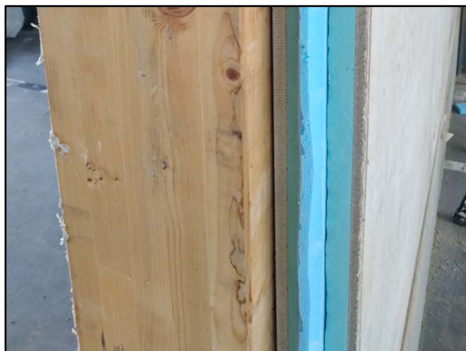
Detalle de colocación del panel sobre soporte estructural, con vista del macho, del panel TFbcY / 12-60-12
