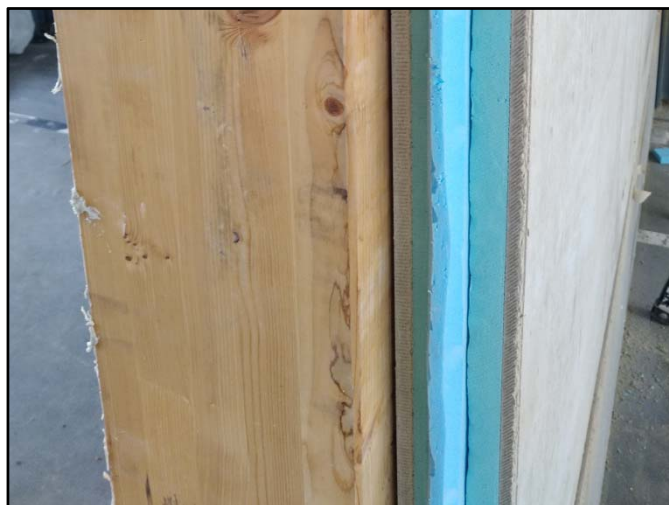
Vista de montaje del panel sobre poste estructural
