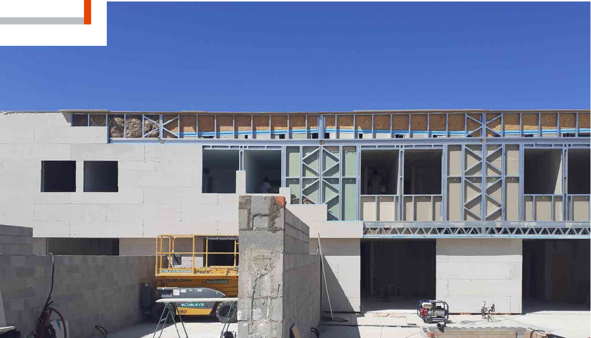
Compuesto de panel exterior TFbcY de núcleo aislante variable y trasdoso interior COAT de doble placa. Disposición de montantes cada 60cm. Acabado exterior libre.
