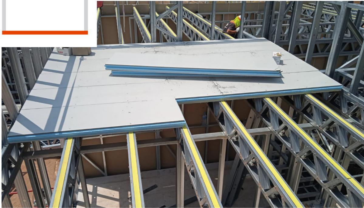
Compuesto por panel interior TYY de núcleo aislante variable, con falso techo interior COAT de doble placa y solera seca sobre panel. Disposición de apoyos cada 60cm. Acabado libre.
