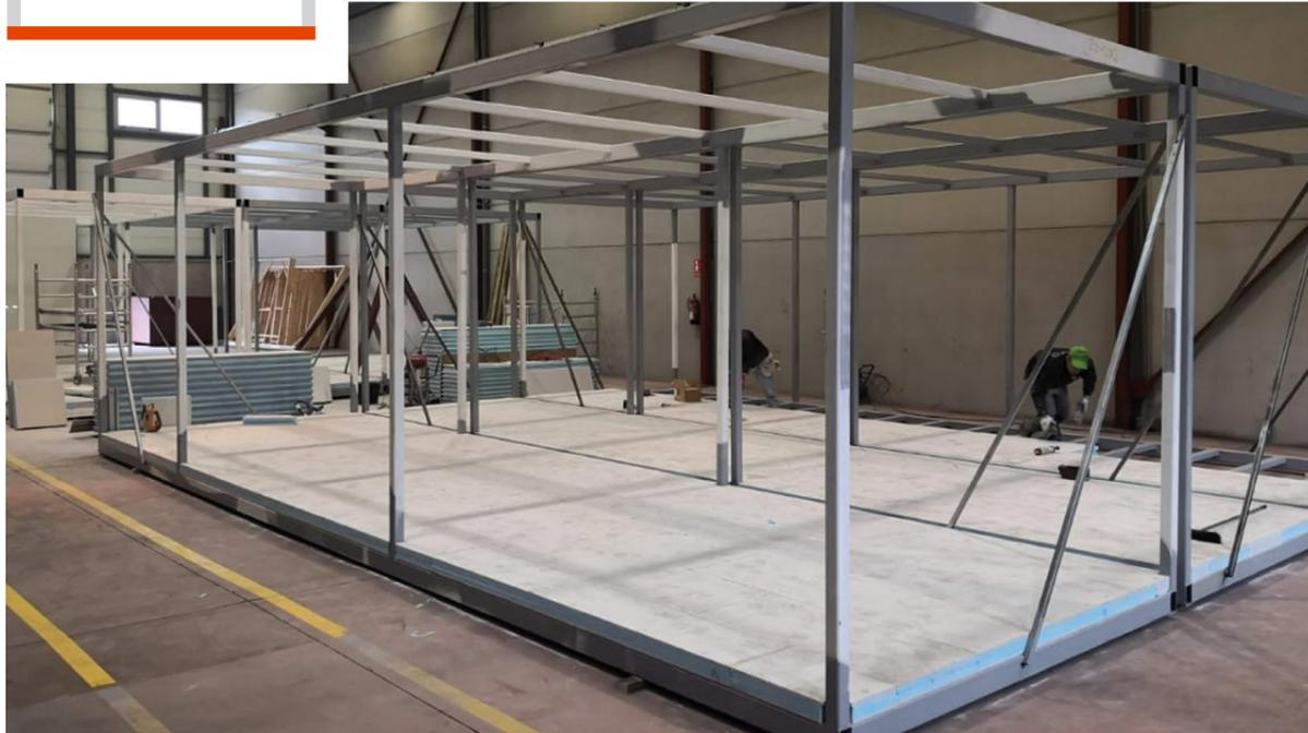
Compuesto por panel exterior TFbcY de núcleo aislante variable y solera seca sobre panel. Disposición de apoyos cada 60cm. Acabado libre.
