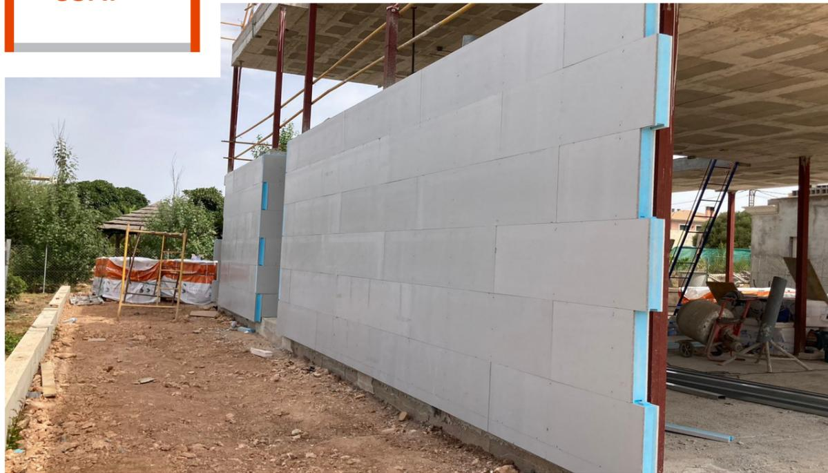
Compuesto de panel exterior TFbcY de núcleo aislante variable y trasdosado interior COAT de doble placa. Disposición de montantes cada 60cm. Acabado exterior libre.
