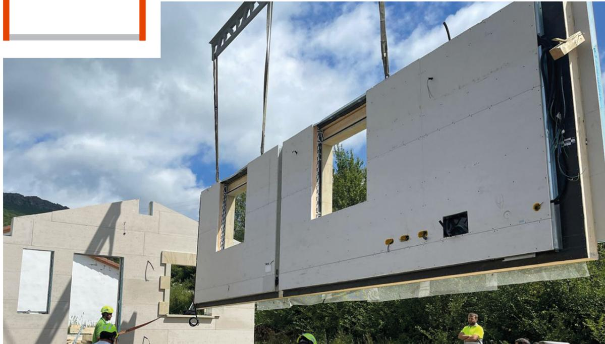
Compuesto de panel exterior TFbcY de núcleo aislante variable, panel interior TYY de núcleo variable y placa de cartón-yeso RF al interior. Disposición de montantes cada 80cm. Acabado exterior libre.
